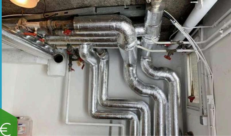
L'isolation des tuyaux de chauffage et d'eau chaude dans les immeubles constitue une mesure cruciale pour prévenir d'importantes pertes de chaleur, entraînant ainsi une réduction significative de la facture énergétique, qui peut atteindre jusqu'à 30 %.
